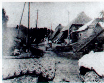
100年前：関東大震災洲崎被害状況
